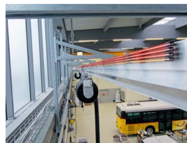
A gauche: pont élévateur 4 colonnes Slift En haut: bras d'aspiration inférieur s.tec A droite: rail d'aspiration s.tec
