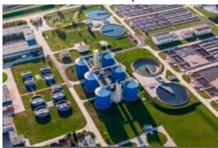
Usines de traitement des eaux usées
